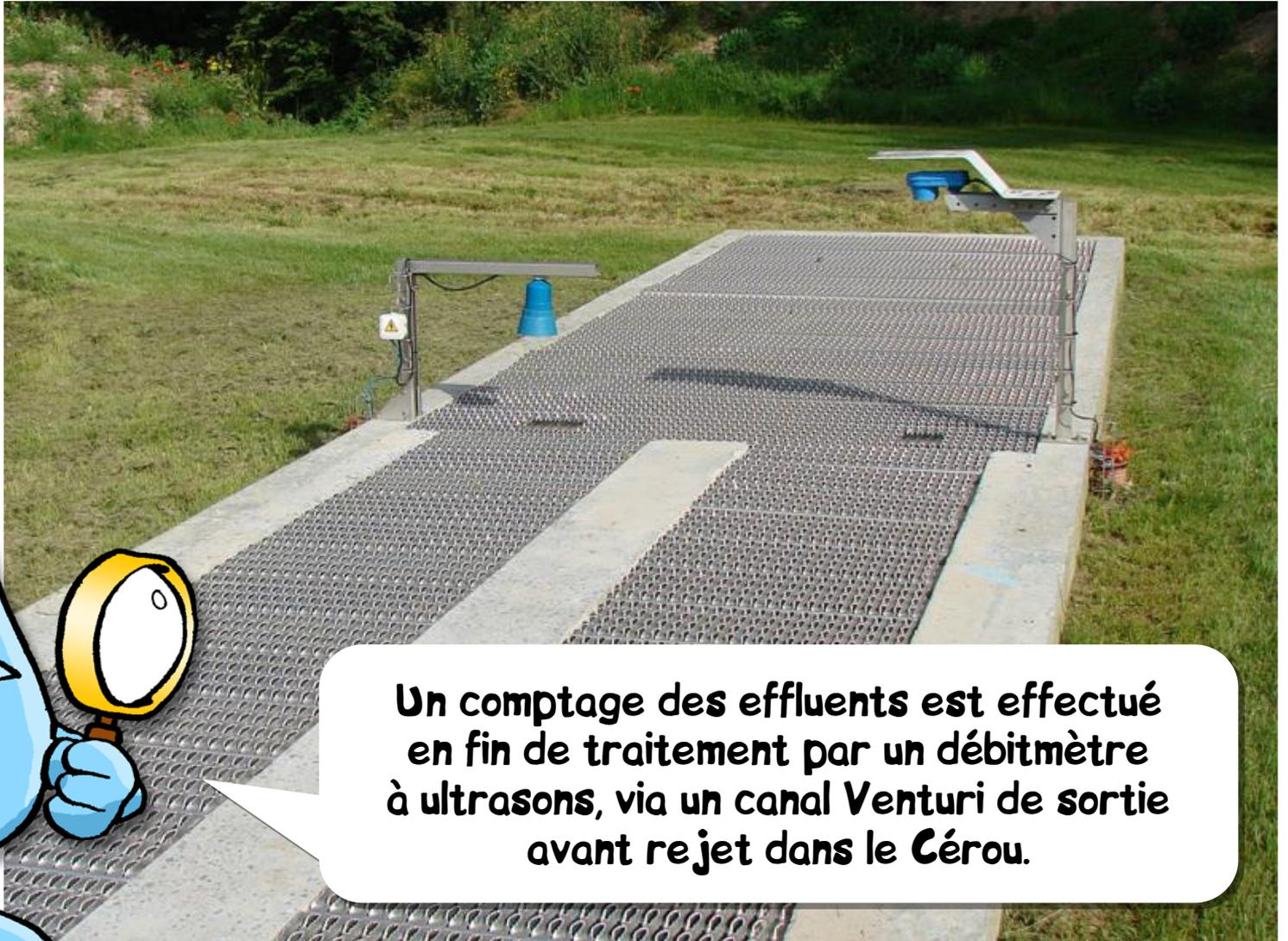
**Un comptage des effluents est effectué en fin de traitement par un débitmètre à ultrasons, via un canal Venturi de sortie avant rejet dans le Cérrou.**
