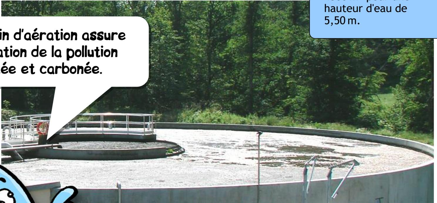
Deux agitateurs brassent les effluents et trois surpresseurs assurent l'aération.
