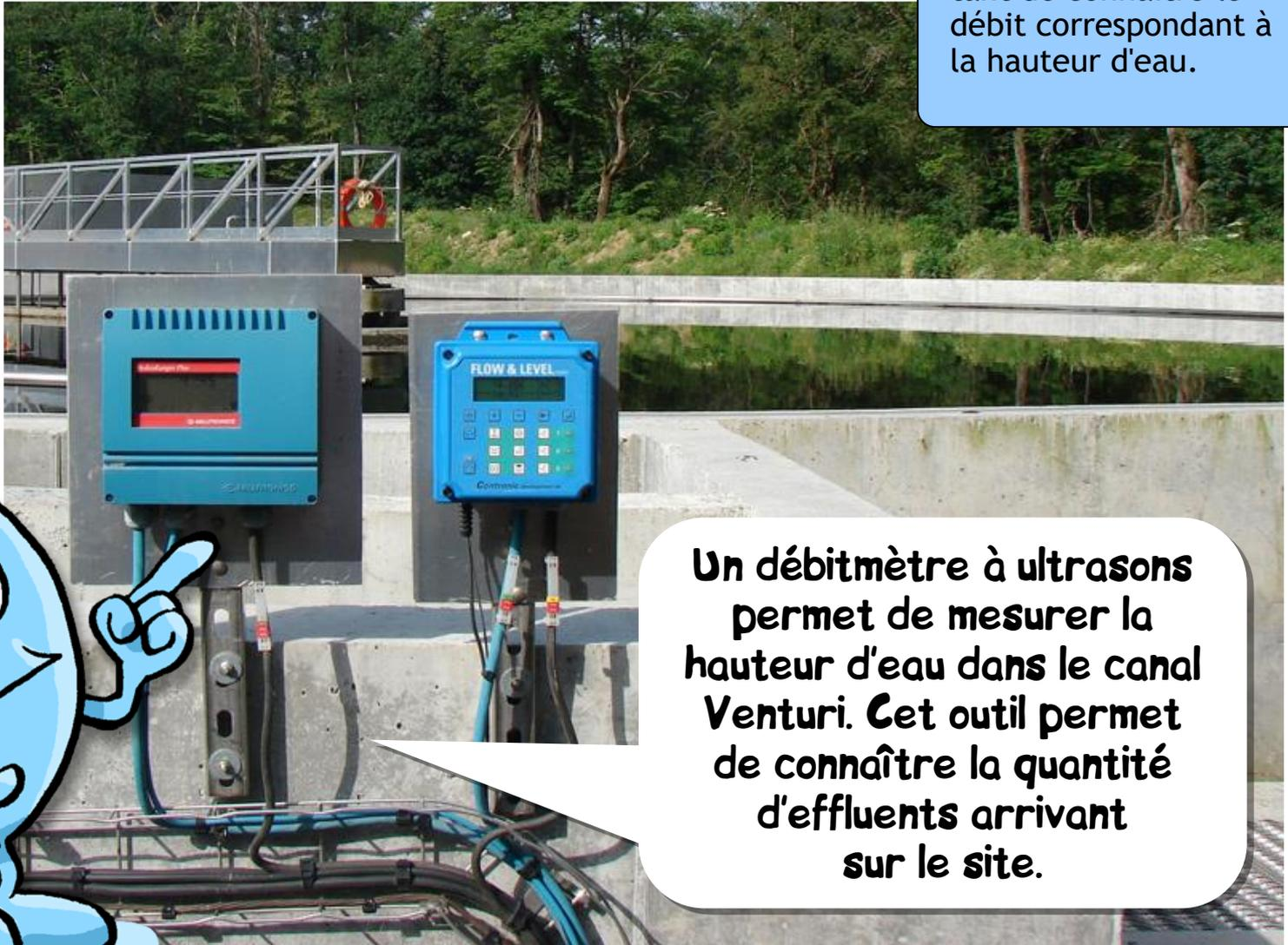
**Un débitmètre à ultrasons permet de mesurer la hauteur d'eau dans le canal Venturi. Cet outil permet de connaître la quantité d'effluents arrivant sur le site.**
