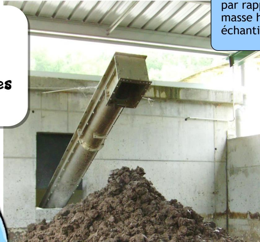
On passe donc de boues liquides à des boues pâteuses d'environ 30% de siccité, soit 10 fois plus sèches qu'à leur sortie du silo épaisseur.
