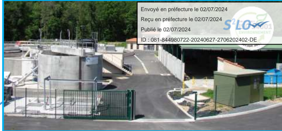
Usine de Dépollution des Eaux de Valarens (21 000 eq/h)
