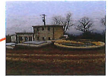
Station de production de Pampelonne (45 m 3 /h)
